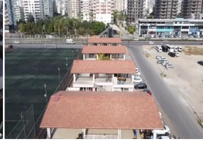
Özgecan Etüt Merkezi GES Projesi: 80 kW-AC
