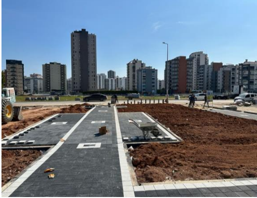
Batıkent Mahallesi 26101 Yeni Park Yapım Aşaması
