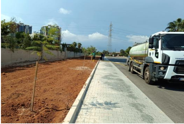
Fuat Morel Mahallesi 28169 sokakta
