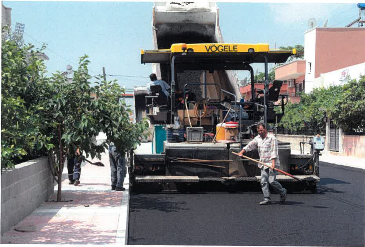
Asfalt çalışmalarından bir görüntü
