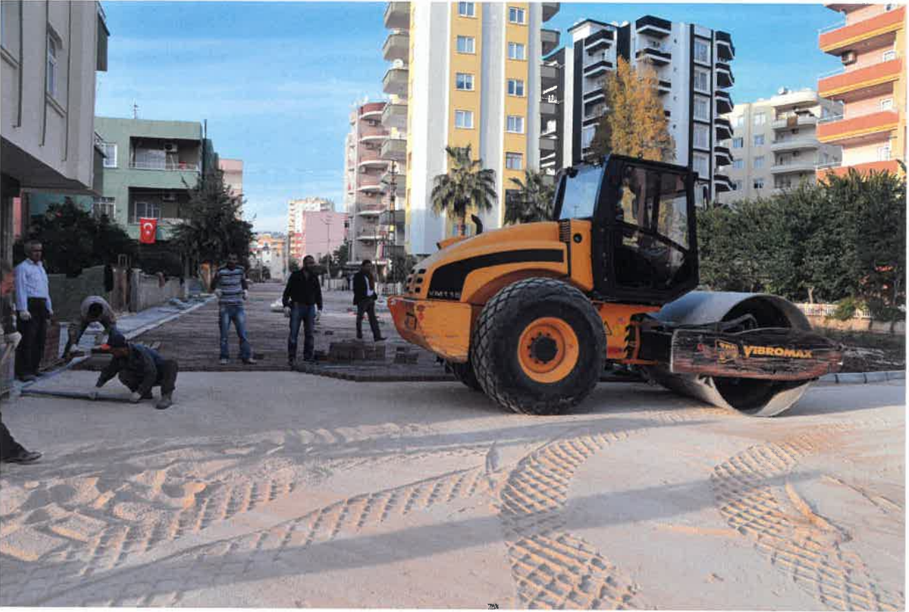
Kilit Parke Yapım Çalışmaları
