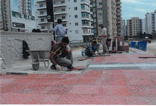
Karo kaldırım ve yol gövdesi yapım çalışmaları
