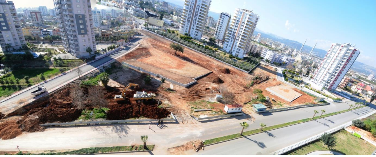
5-50. Yıl Mahallesi rekreasyon alanının yapım işi devam etmekte olup % 9 seviyesindedir.
