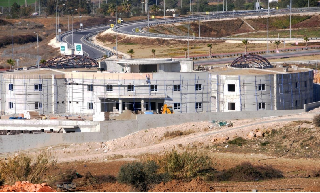
2-Bölgemizdeki Alkol ve Madde Bağımlıları rehabilitasyon için 57 yataklı AMATEM binası yapım işi devam etmekte olup %51 seviyededir.
